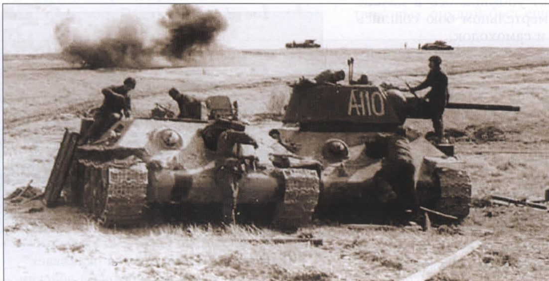
Ремонт подбитых Т-34 часто производился прямо по ходу боя. Инженерный танк (без башни) стоит рядом с ремонтируемой «Тридцать-четверкой»
